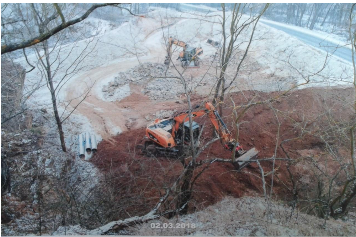
Foto č. 2 – zemní práce v dotčené lokalitě v k. ú. Kobeřice, foto ze spisu stavebního úřadu.
